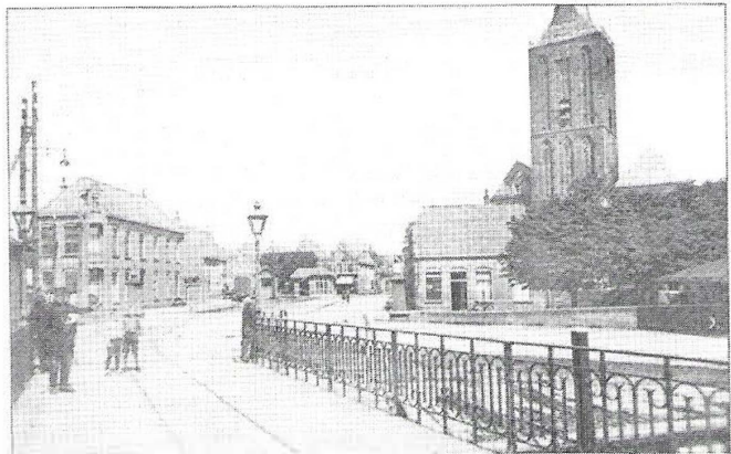
De brug met tramrails en de brugwachters.
